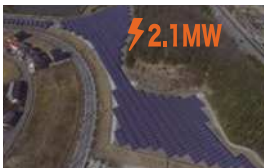
4 兵庫県・加東市 2,120kW 6,840枚 2016年1月系統連系 ⚡2.1MW
