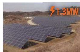
9 宮城県・大郷町 1,272kW 5,096枚 2014年2月系統連系 ⚡1.3MW
