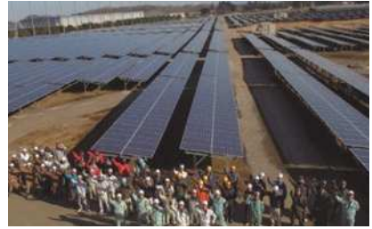
3 茨城県・結城市 13,680kW 54,774枚 2015年3月系統連系 ⚡14MW
